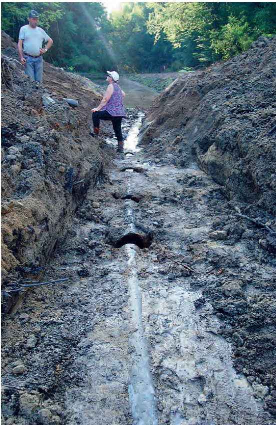
Aperçu général des tuyaux ciment qui contenaient des tuyaux plastique.
